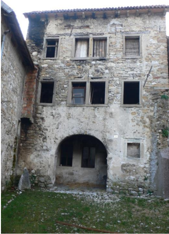
3 CASA RESIDENZIALE CON PORTICATO Lamosano di Chies d'Alpago
