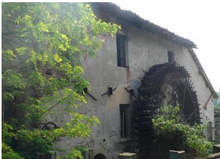
Particolare della ruota di un mulino ad acqua
