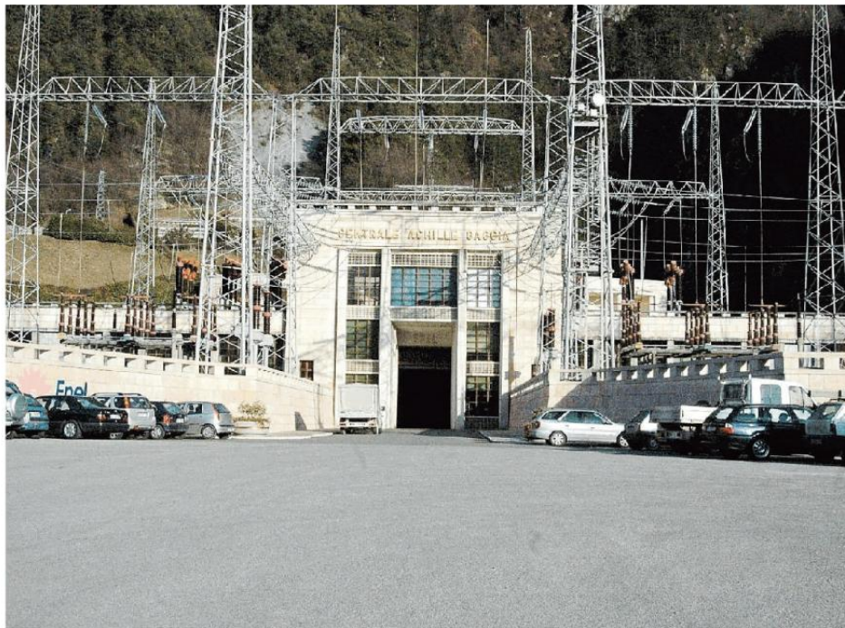
La centrale idroelettrica di Soverzene
